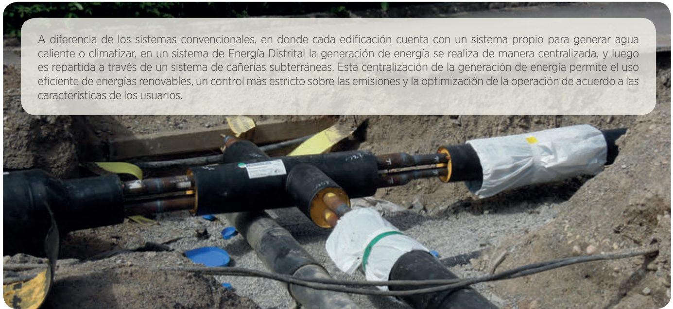
Figura 1-2 Vista de las tuberías que componen el sistema de distribución para una red de Energía Distrital. Autor: Dependability, bajo licencia CC BY-SA4.0
