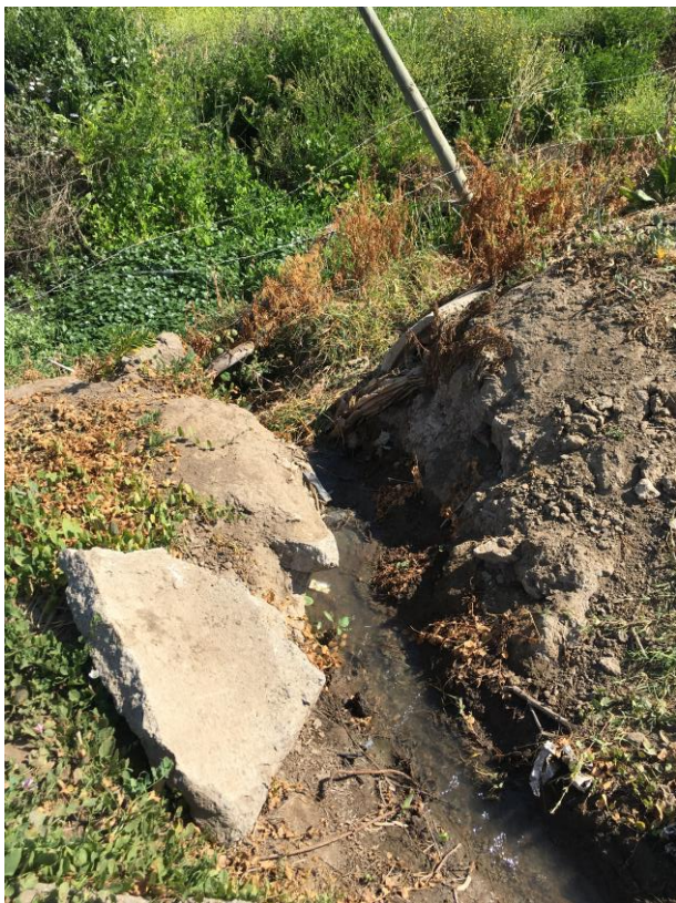
SIFÓN COLAPSADO
